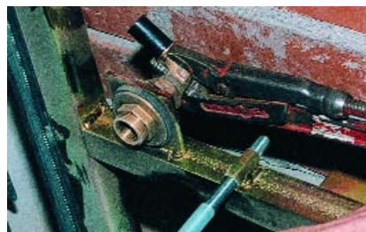
Hanf und nicht aushärtende Dichtpasten (nach DIN EN 751-2) dienen auch heute noch zum Eindichten von Withworth-Rohrgewinden
