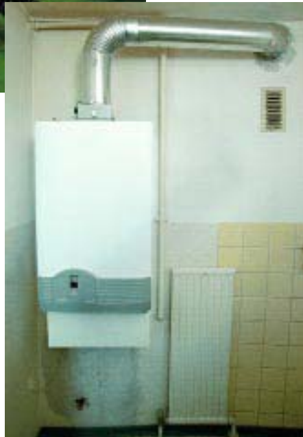
Anlage 1 Gemeinsame Nutzung eines Schornsteins für Heizwert und „Cerapur-Kamin“ in einem Mehrfamilienhaus
