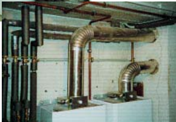
Anlage 7 Zweifamilienhaus mit zwei Brennwertgeräten an einem Schornsteinzug. Schornstein ohne Maßnahmen trocken
