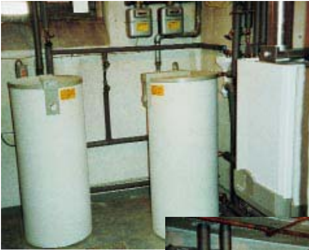
Anlage 7 Zweifamilienhaus mit zwei Brennwertgeräten an einem Schornsteinzug. Schornstein ohne Maßnahmen trocken
