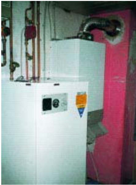
Anlage 2 Zweifamilienhaus mit einem Gerät und Warmwasserspeicher
