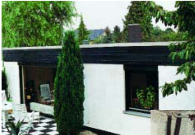
Anlage 4 Einfamilienhaus mit Flachdach. Schornstein ist trotz Maßnahmen feucht
