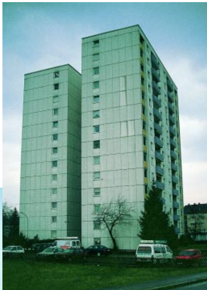
In den beiden Hochhäusern waren die Trinkwasserinstallationen von insgesamt 106 Wohnungen zu sanieren
