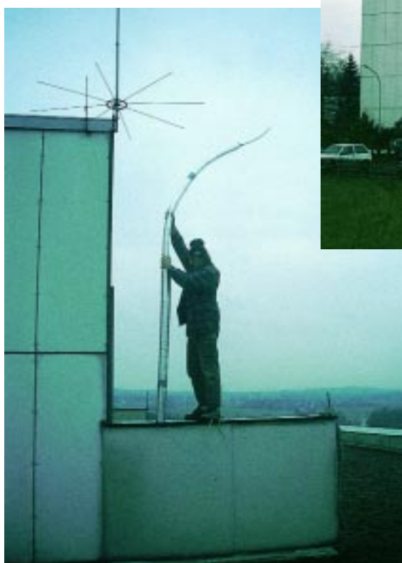
Installateurmeister Klaus Rötzer verpreßte die Steigleitungsabschnitte von jeweils fünf Etagen auf dem Flachdach und führte sie in die stillgelegten Schornsteine ein...
