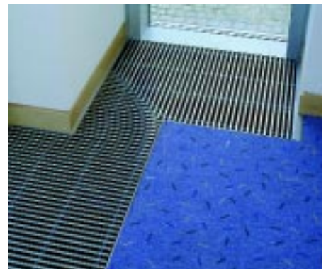
Bild 15 Konvektoren-Unterflurschacht, mit Roll-Rost und Gehrung
