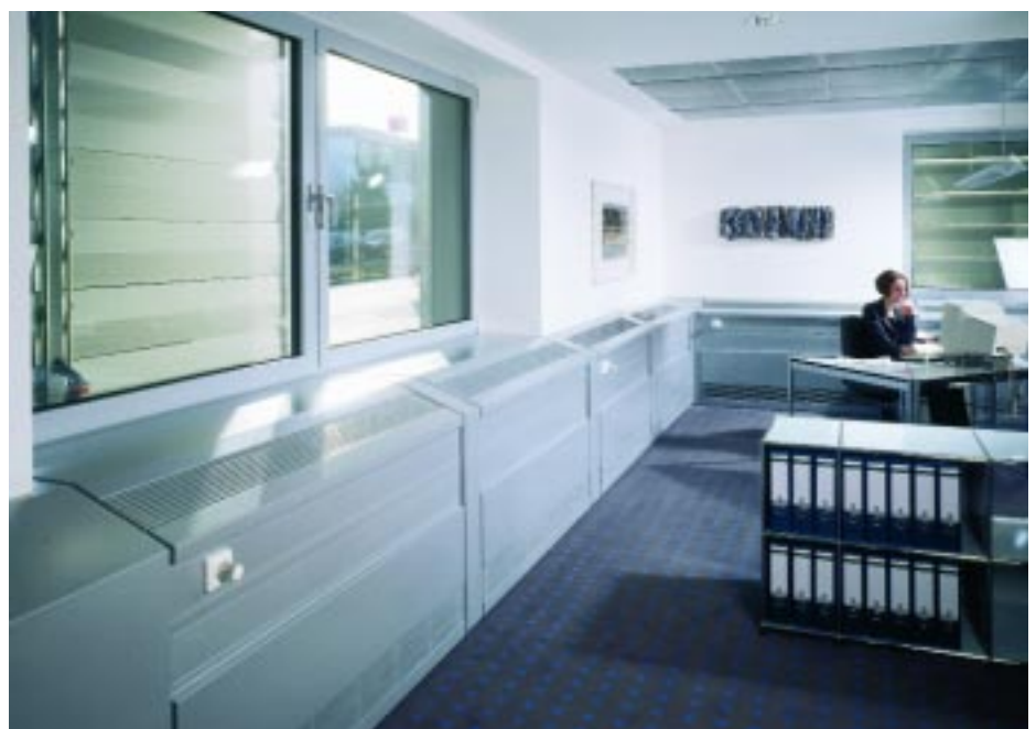
Bild 10 Brüstungsverkleidung mit Gehrungsecke im Pressevertriebszentrum Mölk, Osnabrück
