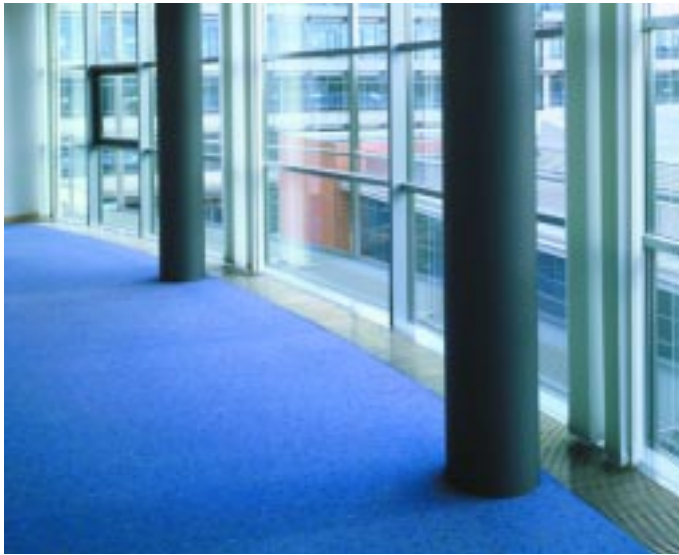
Bild 16 Runder Unterflurschacht im Verwaltungsgebäude HUK Coburg
