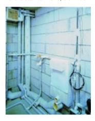
nem integrierten Schnellverschluß versehen sind. Sie werden z.B. für Winkel und T-Stücke von Rohrleitungen ab 15 bis 28 mm Außendurchmesser angeboten. Für das Abkleben der
