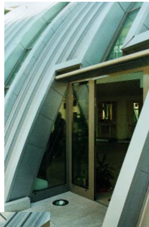
Das mittlere der Lichtbänder erweitert sich zu einem Eingang, in dessen oberem Bereich ein aufgeschnittenes Edelstahlrohr das von den Glasflächen und eine Rundkehle das von den Kalzipscharn abfließende Regenwasser seitlich ableitet
