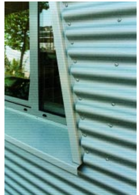
Die Sinusbleche der Seitenwand-Bekleidung wurden – wie hier im Fensterbereich sichtbar – mit Blechschrauben an der Unterkonstruktion befestigt
