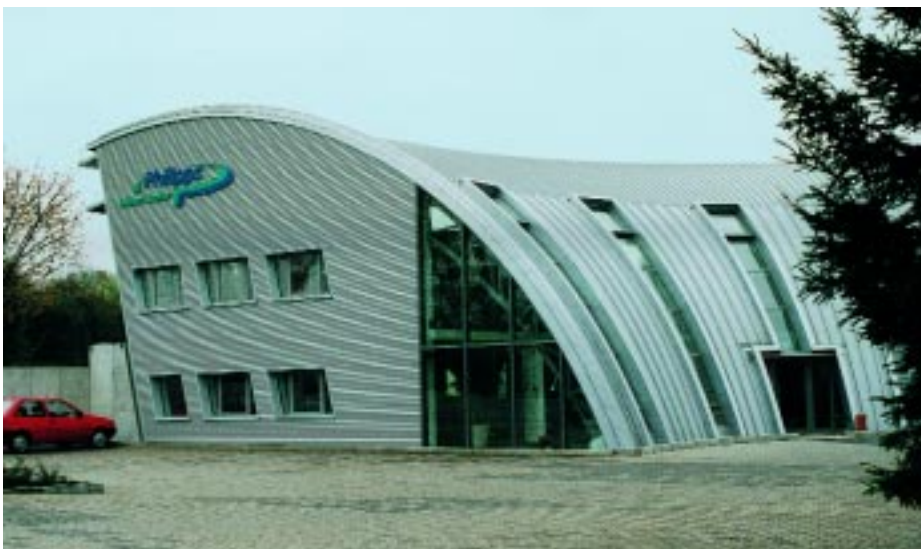
Beindruckend ist jedoch vor allem die Rückansicht mit seinem bis zum Boden reichenden gewölbten Dach und seinen integrierten fünf Lichtbändern
