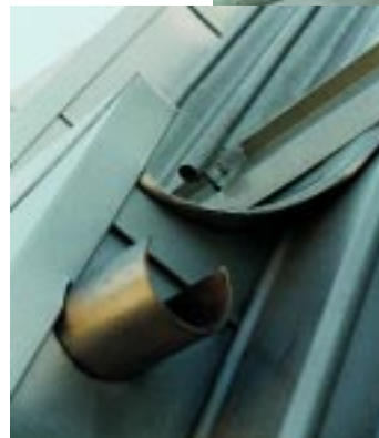
Das mittlere der Lichtbänder erweitert sich zu einem Eingang, in dessen oberem Bereich ein aufgeschnittenes Edelstahlrohr das von den Glasflächen und eine Rundkehle das von den Kalzipscharn abfließende Regenwasser seitlich ableitet
