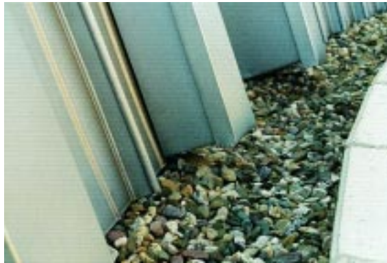
Während im Inneren des Gebäudes die Stahlkonstruktion in einem Gelenk auf dem Betonfundament endet, mündet die Traufe im Innenhof in einer ausgekleideten und mit Grobkies gefüllten Betonwanne
