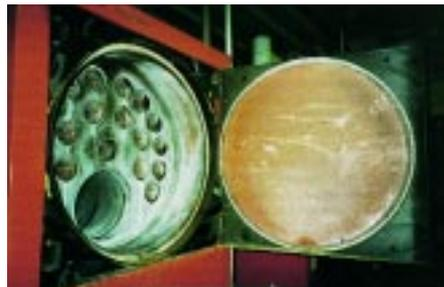
**Bild 16** Eisenhaltige Verbrennungspartikel auf der keramischen Dämmplatte
