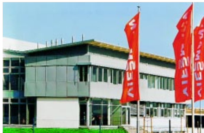
Im neuen Gebäude der Viessmann Verkaufsniederlassung in Prag sind auf insgesamt 2700 m 2 u. a. auch Räumlichkeiten für Schulungen und Ausstellungen vorhanden
