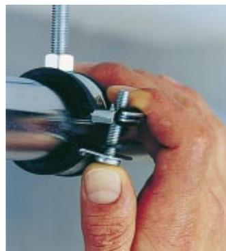
optimale Anpressung der Schallschutzeinlage an das Rohr erreicht. Außerdem wird mit dieser Schelle die Ein-Mann-Montage erleichtert. Die verzinkten Rohrschellen sind als leichte Serie HSR-L für die Nennweiten DN 8 bis DN 50 und in einer mittelschweren Ausführung als Serie HSR-M von DN 8 bis DN 100 erhältlich, wobei die leichte Serie auch mit einer Gleitgummieinlage für Kunststoffrohre lieferbar ist.
