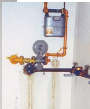
Drückendes Wasser führte bei dieser mangelhaft ausgeführten Rohrdurchführung zu Schäden
