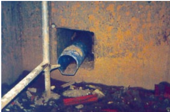
Großzügige Wandaussparung in einer weißen Wanne, für das nachträgliche Einsetzen eines Futterrohres mit Quellbeton
