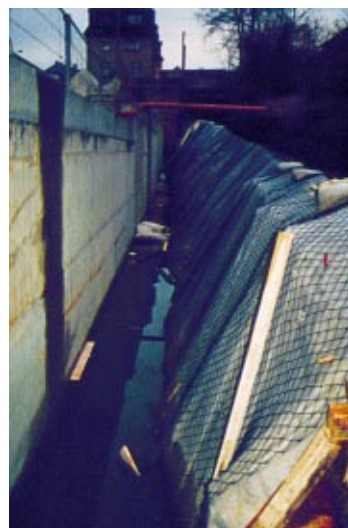
Die sogenannte weiße Wanne aus wasserundurchlässigem Beton ist ein Zeichen für drückendes Wasser...
