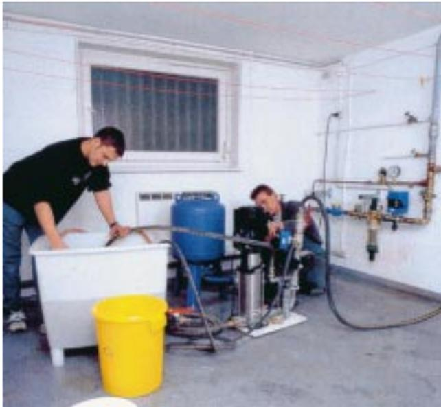
**Vorbereitungen zum Einfüllen der Minerallösung, die reinigt, desinfiziert und Korrosionsstellen versiegelt**
