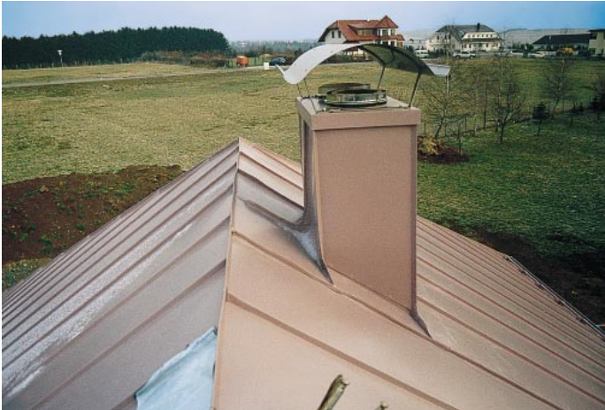
Die Schornsteinkehle wurde als zweiseitiger Sattel, der First, da die Gitterbahn keine Hinterlüftung erfordert, als Doppelstehfalz ausgeführt
