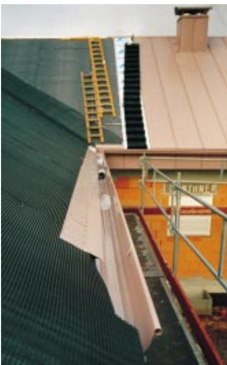
Im Frühjahr wurden die Dachbekleidungsarbeiten fortgesetzt, beginnend mit Dachrinne und Rinneneinhang
