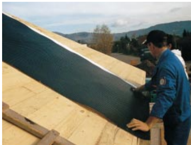
Die Unterspannbahn wird auf der Holzschalung ausgerollt, abgelängt und festgetackert
