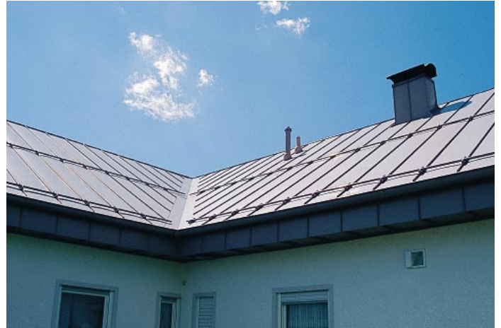
Zur Wetterseite hin brachte Ganter zwei Schneefang Sicherungen an
