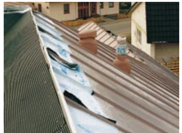
Die Dunsthauben wurden von Klöber im gleichen Farbton geliefert wie das verwendete Farbaluminium der Dachbekleidung
