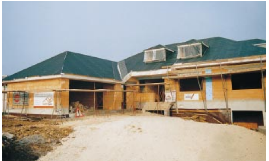
Durch den früh eingetretenen Winter mußte die Diffusionsschicht allein das Gebäude gegen eindringendes Niederschlagswasser schützen
