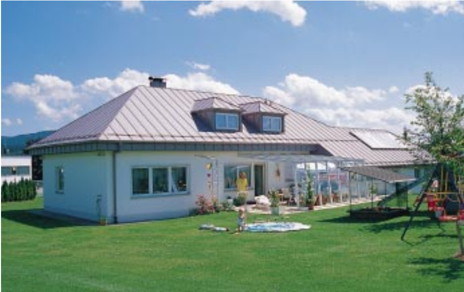
Auf der Gartenseite des Ganterschen Gebäudes sind die Kollektoren für die Warmwasserbereitung auf dem Falzdach befestigt worden
