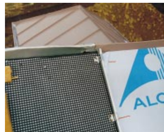
Die Dachbekleidung in Farbaluminium erfordert fachliches Können, denn es kann weder geschweißt noch gelötet werden
