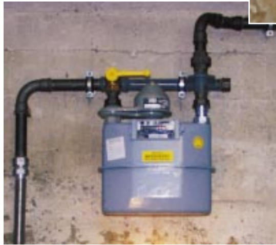
Bis etwa 1980 wurden in die Gasanlage Kondensatsammler und Reinigungs-T-Stücke eingebaut...
