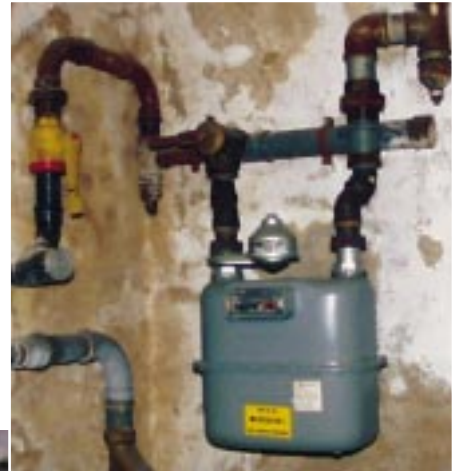
Bis etwa 1980 wurden in die Gasanlage Kondensatsammler und Reinigungs-T-Stücke eingebaut...
