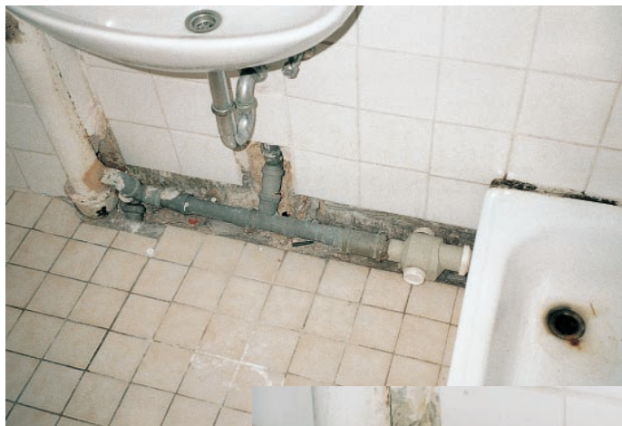
Man beachte den in den Fußboden zusätzlich eingebrachten „Siphon“
