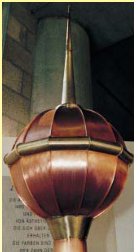
Die Quernaht der „Halbkugeln“ sind durch einen umlaufenden Messingwulst abgedeckt...
