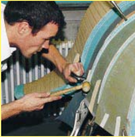
Die Doppelstehfalze der Scharen münden nach oben in der Firstlinie
