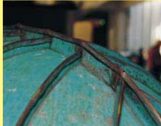
Auch der First ist als Doppelstehfalz ausgeführt, wobei dieser wegen der Materialhäufung durch die Scharenfalze höher ist
