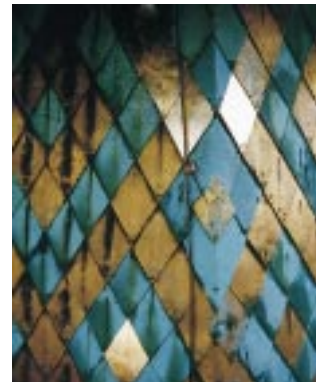
Fertig renovierte Schindel-Bekleidung in der ursprünglichen Ornamentik mit den originären und den erneuerten, teilweise vergoldeten Schindeln
