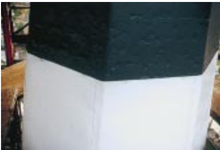
... über dem Einhangstreifen liegt die Trennfolie, die an den Graten überlappt mit Warmluft verschweißt wurde
