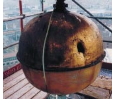
Als unterstes Dekor der Turmspitze dient ein aus zwei halbkugeligen Schalen hergestellter Knopf, der Schußlöcher aufwies und an mehreren Stellen geflickt war
