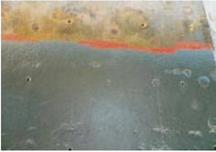
Nach dem Entfernen des Rostes wurde die Stahlschalung mit rotbraunem Grundiermittel und silbergrauem Decklack gegen erneute Korrosion geschützt
