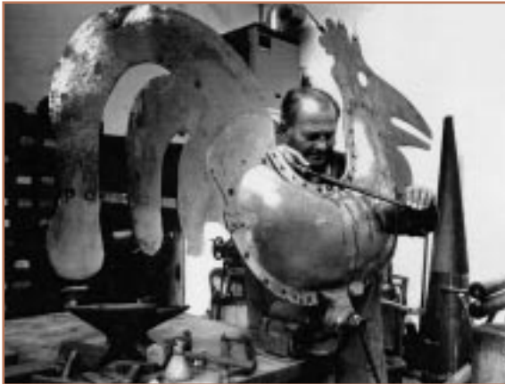
Die Dachbekleidungsarbeiten wurden von der Nürnberger Flaschnerfirma Konrad Kunstmann ausgeführt, dessen Inhaber selbst bei vielen Details Hand anlegte
