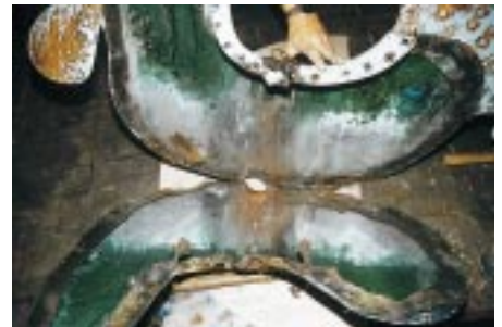
Nach dem Öffnen des Wetterhahnes zeigten sich die durch eindringende Feuchtigkeit hervorgerufenen Korrosionsschäden, ...
