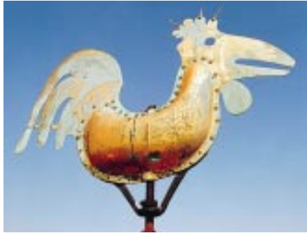
Der ursprünglich bewegliche Wetterhahn, aus zwei getriebenen Schalen hergestellt, die mit Schmuckschrauben zusammengehalten wurden, hing fest und wies Löcher auf
