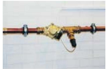
**Nur wenn der Druck während der Ruhephase konstant geblieben ist, gibt die Funktionseinheit bei Bedarf den Querschnitt frei**
