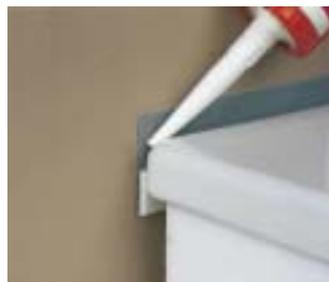
**Schallentkopplung bietet das Dichtband, das an die Wand geklebt wird**
