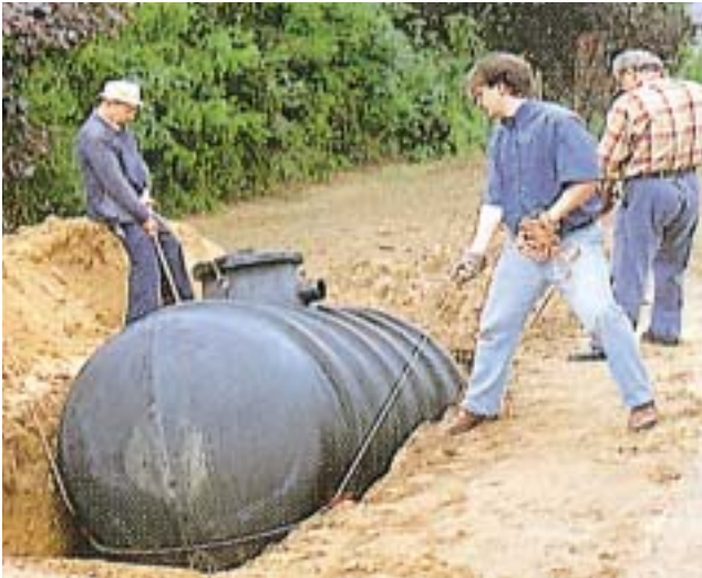
Einbringen des Tanks (Bild: Graf)
