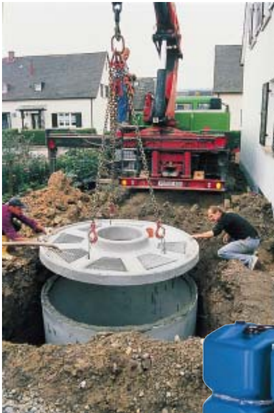
Einbau mit Kran - Betonzisterne (Bild: Mall Beton)
