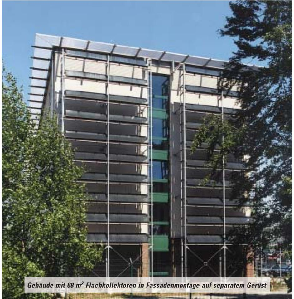
Gebäude mit 68 m<sup>2</sup> Flachkollektoren in Fassadenmontage auf separatem Gerüst
