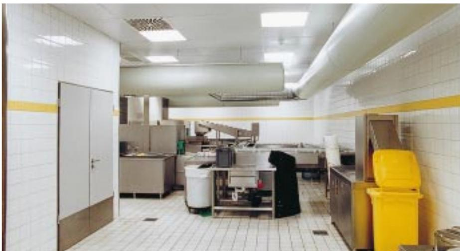
*Die zugfrei arbeitenden Textilschläuche ermöglichen auch in der Spülküche angenehme Arbeitsbedingungen. Selbst höhere Luftwechsel zur Abfuhr feuchter Luft werden problemlos bewältigt*
