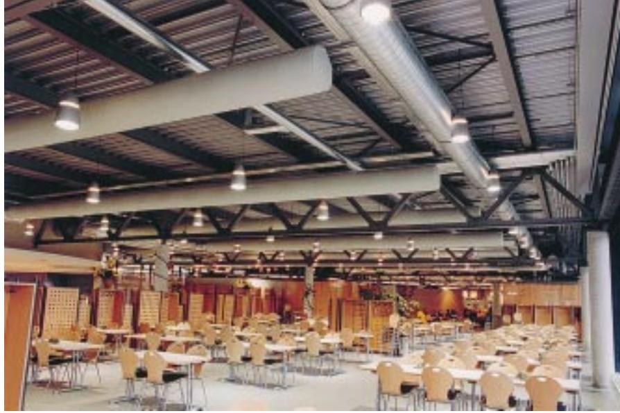
*Textilbasierte Lüftungssysteme haben sich z. B. in sensiblen Industrieklimaanlagen bewährt. Nun finden die Textilschläuche mit der Doppelfunktion Lufttransport und Luftverteilung auch für andere Bereiche immer mehr Befürworter. Das Lüftungssystem im neuen Betriebsrestaurant der BASF in Ludwigshafen ist ein Beispiel dafür.*
