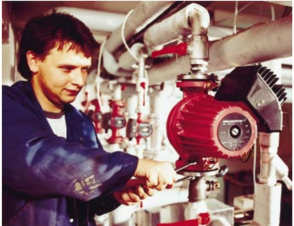
Bild 5 Montage einer Elektronikpumpe
