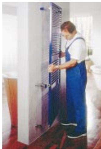
stimmt werden. Jeder gewünschte Nabenabstand ist lieferbar, wodurch die Anschlußmaße aller gängigen alten Heizkörpermodelle abgedeckt werden. Die Austauschmodelle gibt es sowohl bei Design-Wärmekörpern für das Bad, beispielsweise dem Zehnder Universal, als auch bei Wohnraum-Wärmekörpern, wie dem Zehnder Mehrsäuler. Bei denen kann das Thermostatventil ganz variabel
