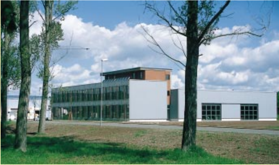
Die Vorderseite des neuen Betriebsgebäudes in Weil der Stadt ist als Glasfassade, unterbrochen von hölzernen Lamellen, gestaltet, während die Brüstungen und die Seitenwände mit Aluminiumwellblech bekleidet sind
