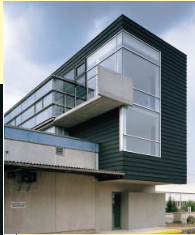
Anthrazitfarben vorbewittertes Titanzinkblech wählten Bauherr und Architekt für die Fassadenbekleidung eines Gewerbebaus im Hamburger Osten (Barsbüttel) – aufgelockert durch Einschnitte und Glasflächen
