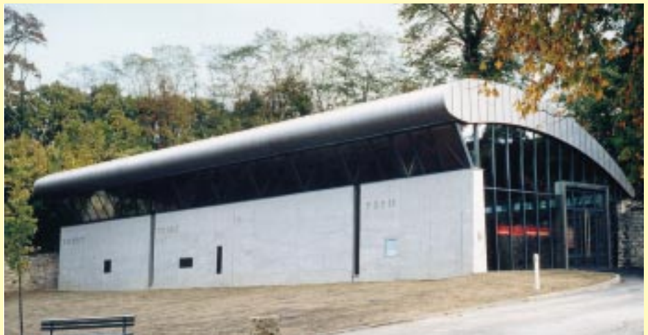
An eine Tragfläche erinnert das geschwungene Dach des „Hauses der Steine“, das mit glasgestrahltem Blech aus Chrom-Nickel-Stahl bekleidet wurde
