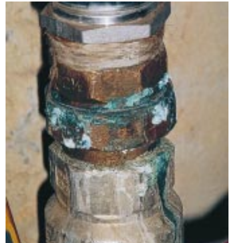
Sieht aus wie „Grünspan“ oder Korrosion durch Flußmittelrest. Die weißlichen Ausblühungen an den Verschraubungen lassen aber auf elektrisch bedingte Korrosion schließen [2]
