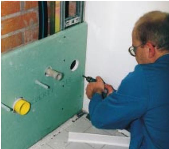
Die Gipskartonplatten werden am GSI- und am BSI-Masc-Gestell im Abstand von etwa 150 mm mit Bohrschrauben befestigt, die Fugen mit imprägnierendem Spachtel verschlossen
