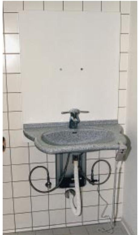
Eine Abdeckplatte, zwischen Waschtisch und Hubelement montiert, kann zur Anbringung eines Spiegels oder Spiegelschranks sowie einer Ablageplatte genutzt werden
