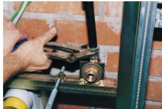
*Als Anschlußleitung wählte der Installateur Mepla-Verbundrohr mit Schutzrohr, das in der verwendeten Dimension von 20 mm per Hand verpreßt werden kann*
