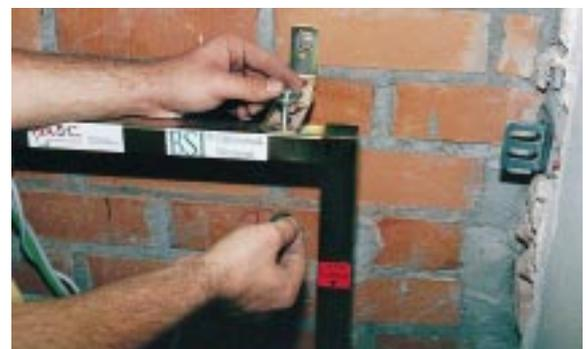
Bei der Renovierungsmaßnahme in Stuttgart wurde das VWI-Montageelement mittels Anschlußwinkeln an der Wand befestigt. Auch für die Befestigung des zusätzlichen GIS-Gestells wurden entsprechende Langlochwinkel angebracht (r.)
