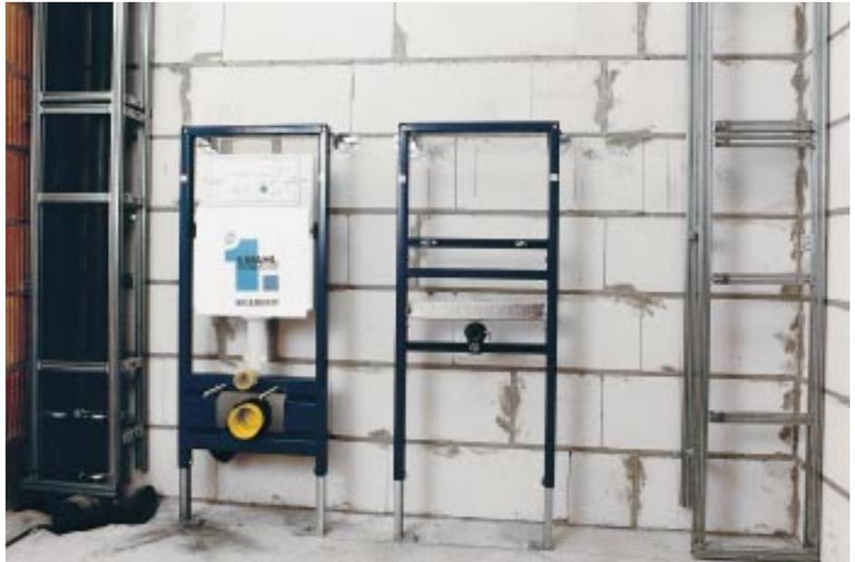
*Für die Einrichtung des Badezimmers in einem Ahleener Mehrfamilienhaus werden vorerst die blauen Duofix-VWI-Elemente und die GIS-Schachtkonstruktionen separat montiert*
