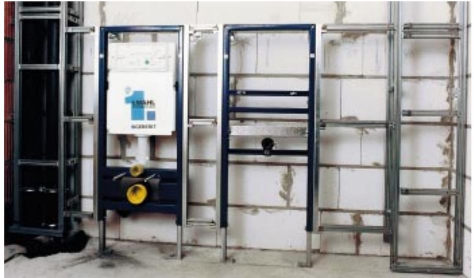
Nachdem alle Zwischenstücke zwischen Adapterschienen und Schachtkonstruktionen angebracht wurden, kann mit der Rohrinstallation fortgefahren werden
