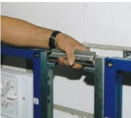
Die auf Maß zugeschnittenen GIS-Profilstücke klickt der Monteur in Federstahlspangen ein, die an der Adapterschiene befestigt sind
