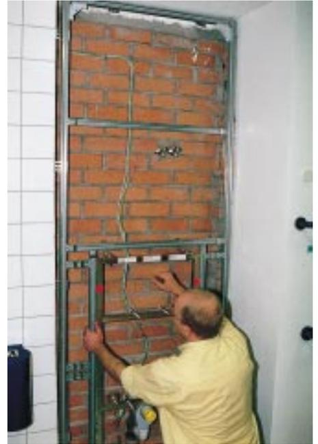
*Das GIS-Gestell wird an den seitlichen und oberen Winkeln mittels Drehrastbolzen und Innensechskantschrauben befestigt und an die Bautiefe des bereits eingebauten VWI-Elements angepaßt*
