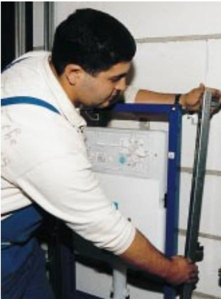
Über zwei Nasen lassen sich die Adapter-schienen in seitlich an den Rahmen der Montageelemente befindliche Langloch-Ausparungen einhängen ...
