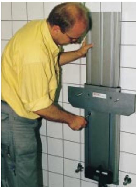
Nach Beendigung der Fliesenlegerarbeiten erfolgt die Befestigung des Hub-Elements mittels Senkkopfschrauben am VWI-Gestell
