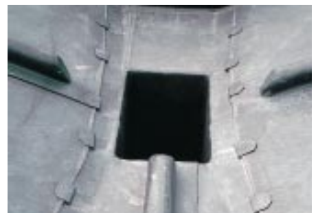
Kehlrinne mit Sammelkasten und mittig davor endender Holzkerne; Sicherheitsüberlauf tiefer liegend
