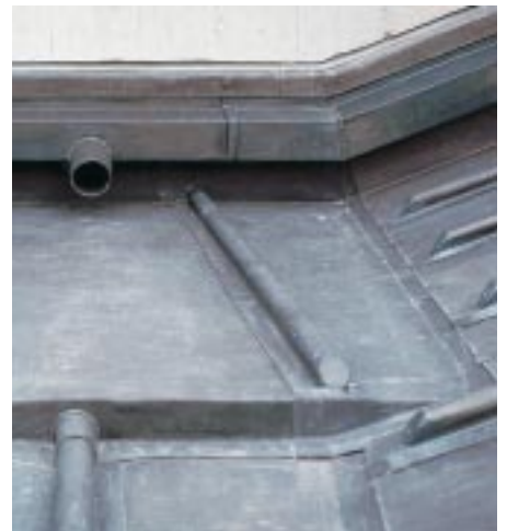
Kehlrinnen mit Gefälleversprung im Bereich des Wandanschlusses sowie belüfteter Wandanschluss mit zwei Gehrungen und eingebautem Rohrauslauf
