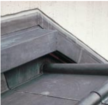
Belüfteter Wandanschluß mit eingeschweißter Firstkappe
