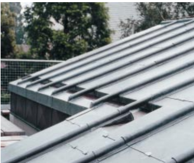
Standrinne mit durchlaufenden Bleiwulsten
