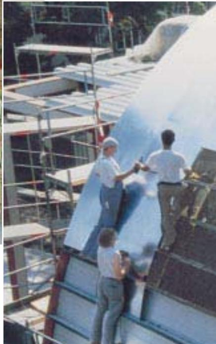
*Walze – Tonnendach: Die Dampfsperre besteht aus verzinktem Stahlblech, unter der sich eine 140 mm dicke Wärmedämmung befindet... [2]*
