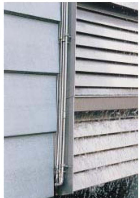
**Kaskadenturm:** Zwischen TiZn-Bekleidung und CrNi-Kaskadenfläche wurde beidseitig ein Kanal angeordnet, in dem die Versorgungsrohre zu den einzelnen Kaskadenrinnen führen
