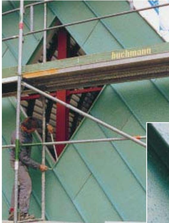
**Walze – Westfassade:** Die Fassade des Haupteingangs erhielt eine Bekleidung in Winkelfalztechnik, deren Scharen im Winkel von 60° verlegt wurde, wobei es an der linken Ecke des rhombenförmigen Fensters (kleines Bild) einer besonderen Lösung zur Regenwasserableitung bedurfte
