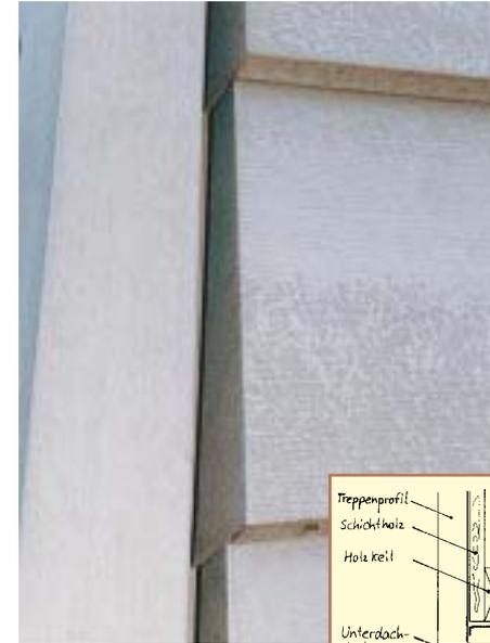
**Kaskadenturm:** Die Grate des Turmes bildet ein omegaähnlich geformtes Profil, in dessen rinnenförmig ausgebildete Flanken die seitlichen Abkantungen des Treppenprofils hineinreichen
