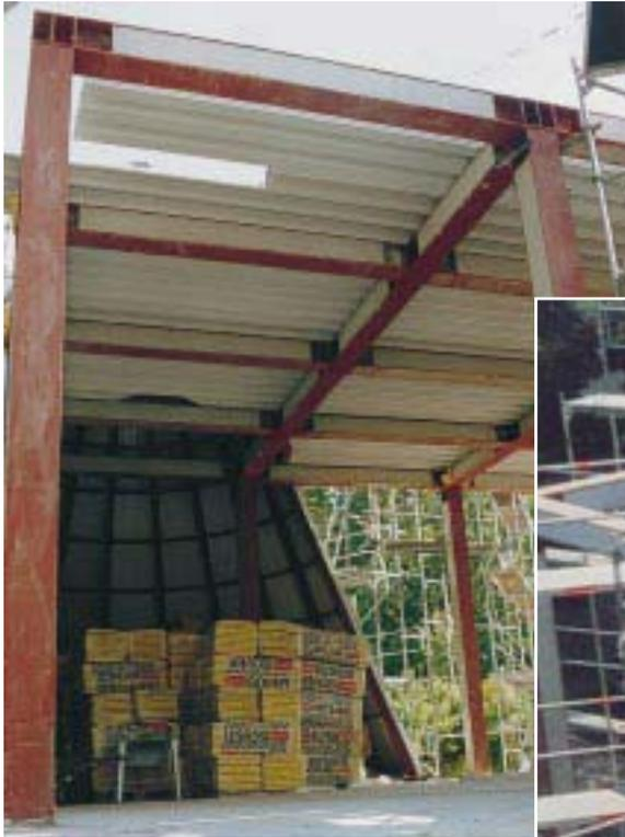
*Das Gebäude ist in Skelettbauweise aus Doppel-T-Stahlprofilen errichtet, die teilweise mit Beton ausgefacht sind. Die Unterkonstruktion des Flachdaches besteht aus Trapezprofilen*
