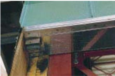
**Walze – Tonnendach:** Die Abführung des Niederschlagswassers erfolgt über Dachrinne und Fallrohre, die verdeckt im Bereich des Fensterbandes angeordnet sind
