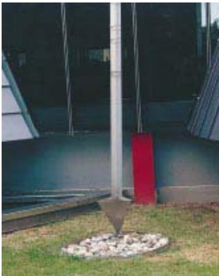
*Zentralbau: Die Entwässerung des Gründaches erfolgt über eine offene Ablaufrinne, an deren Anfang und Ende je ein Tetraederkasten angebracht ist, der die gleichen Neigungswinkel zeigt wie die der Türme zu beiden Seiten*
