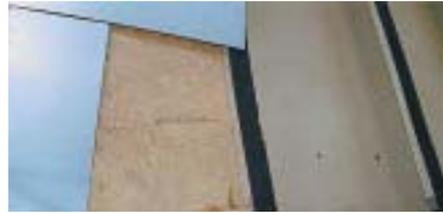
**Blick in die Unterkonstruktion des Kegelturmes (v. r.): Die Schalen aus beschichtetem Stahlblech, Verfüllung mit Wärmedämmmaterial, Dampfsperre aus verzinktem Stahlblech**
