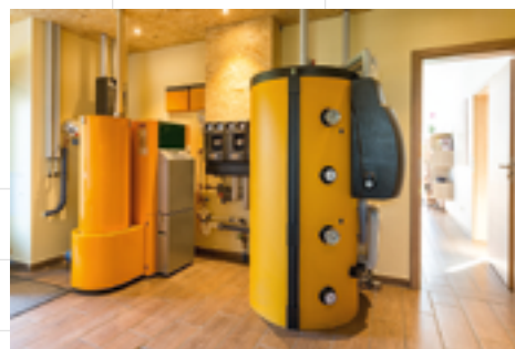
Pelletzentralheizung
