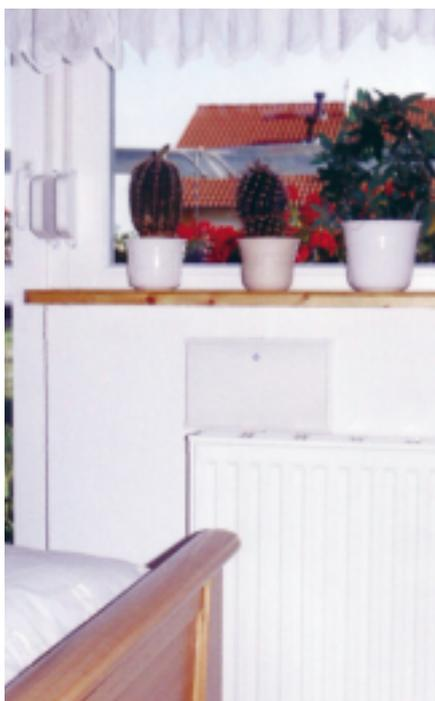
**Bild 6** zeigt die Innenansicht des Außenwand-Luftdurchlasses
