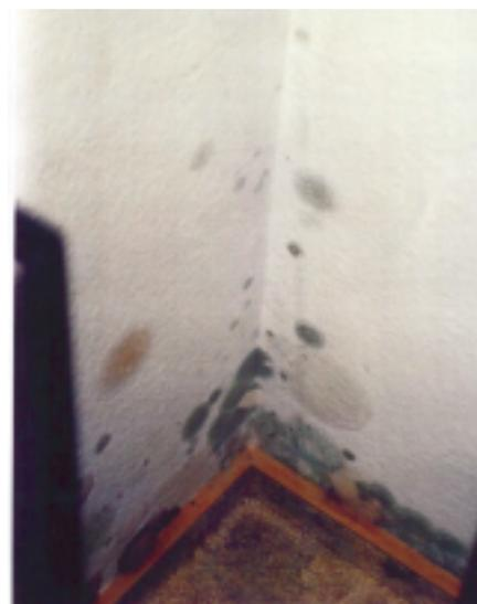
**Bild 2** zeigt Schimmel infolge zu hoher Luftfeuchtigkeit in Verbindung mit einer exponierten Gebäudestelle
