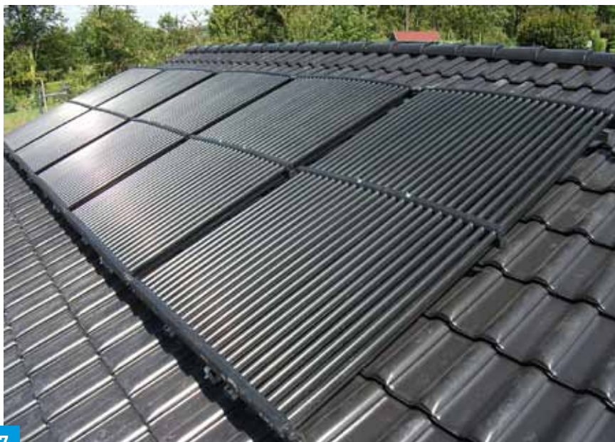
Solar-Luftabsorber für den Betrieb in Anlagen mit Eisspeicher und Wärmepumpe auf dem Dach eines Einfamilienhauses.
