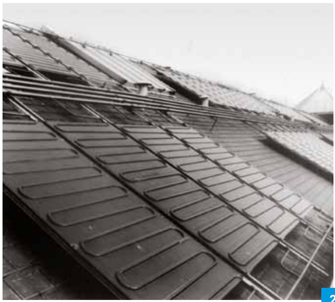
2 Versuchsanlage: unverglaste Absorber als Sammler für solare Wärme zum Betrieb von Sole/Wasser-Wärmepumpen (Viessmann 1981).
